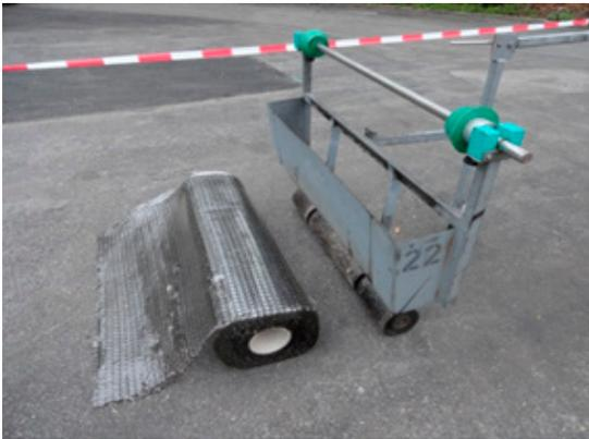
Préparation de la machine de déroulement manuel S&P et de la grille de renforcement.
