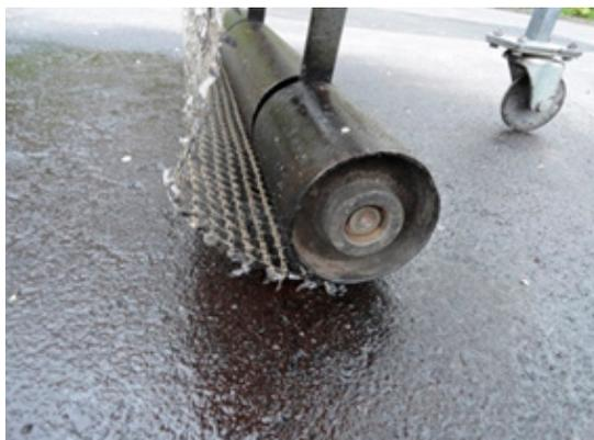
Passer la grille de renforcement S&P sous les rouleaux de marouflage en prenant garde que le film à brûler soit face au support (bitume).
