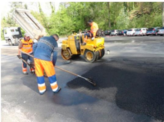
S&P recommande de saupoudrer la grille de renforcement S&P appliquée localement avec de l'enrobé.
