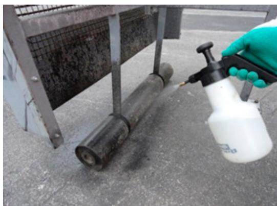
Vaporiser les rouleaux de marouflage avec un agent séparateur couramment utilisé dans la pose d'enrobé.
