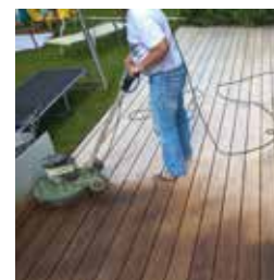
Huilage avec une mono-brosse (également possible manuellement)
