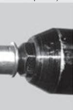
Stülpdeckung sichtbar (Plattendicke 8 mm) oder unsichtbar (Plattendicke 12 mm) befestigt: Niet mit aufgesetzter 16 mm langer Festpunkthülse
