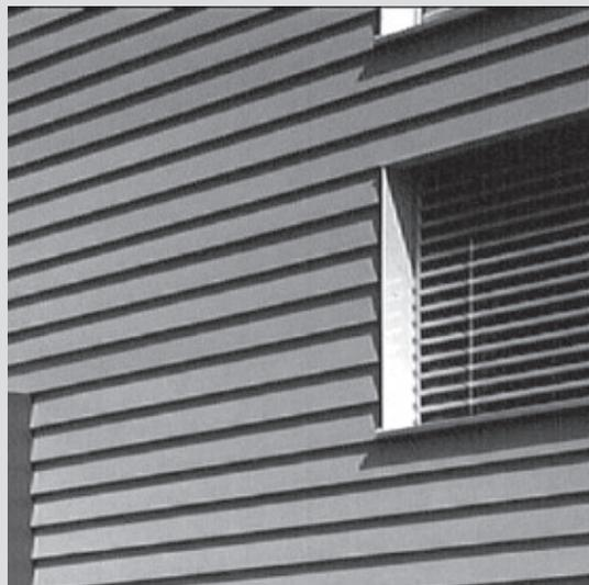
*Fassadenplatten voneinander abgesetzt, Befestigung unter der Überlappung.*
