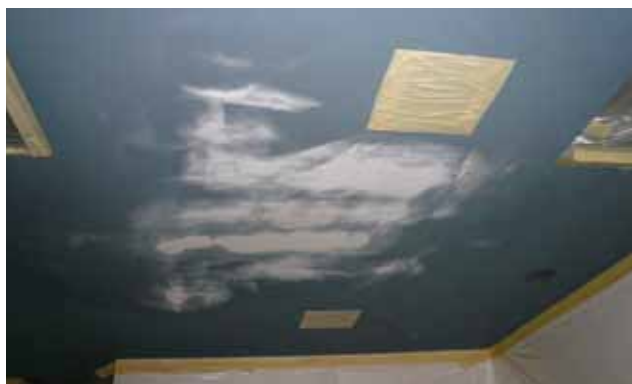
3. Trockene Fugen schmirgeln und Putz in diese Bereiche spritzen
