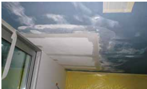
2. Neues Paneel installieren und Ränder auffüllen
