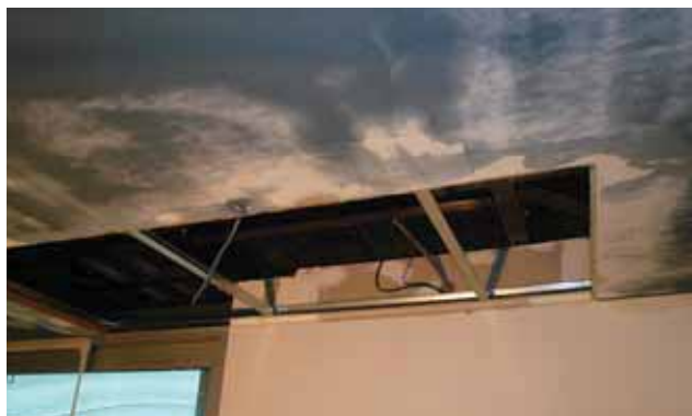
1. Beschädigte Paneele entfernen und umliegende Bereiche schmirgeln
