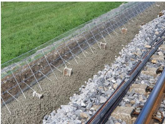
7 Die Bodenpartie der Winkelgitter wird nun mit Sickerbeton min. 5 cm – max. 10 cm überbetoniert. Danach ist zu warten bis der Sickerbeton ausgehärtet ist damit das Winkelgitter unter der Last des Schotters nicht nach aussen kippt.
