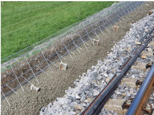
6 Die Bodenpartie der Winkelgitter wird nun mit Sickerbeton min. 5 cm – max. 10 cm überbetoniert. Danach ist zu warten bis der Sickerbeton ausgehärtet ist damit das Winkelgitter unter der Last des Schotters nicht nach aussen kippt.
