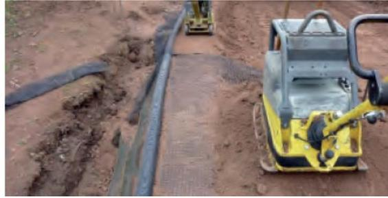
**8** Die weiteren Steilböschungsnetze dürfen nicht direkt übereinander ohne Abstand verbaut werden. Vertikal muss mindestens ein Abstand von 10 cm zwingend eingehalten werden. Sonst besteht die Gefahr, dass sich das untere Netz verbiegen könnte.
