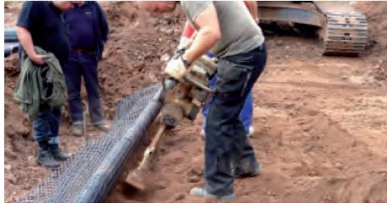
**6** Danach wird das Füllmaterial im Frontbereich in einer Breite von 50 cm eingebracht und verdichtet, bis die vorgesehene Schichtdicke von 60 cm erreicht wird.
