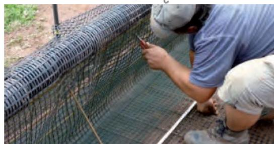
**5** Erdmaterial in Schichten von 30 cm, mit einem Zusammendrückungsmodul von  $ME > 200 \text{ kg/cm}^2$ , vor Kopf einbringen und mittels Rammax und Grabenstampfer verdichten. Es ist zudem darauf zu achten, dass die Steilböschungsnetze und die Zugdrähte beim Verdichten nicht verformt werden. Der Weg des künftigen Wasserlaufs ist Beachtung zu schenken. Es darf kein Wasserdruck auf die neue Böschung ausgeübt werden.
