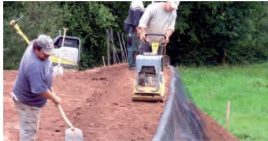
**7** Das Geogitter wird nun, sofern die Steilböschung im Umschlagverfahren erstellt wird, zurückgeschlagen und mit Schüttmaterial so fixiert, dass es sich an der Abtreppung mit Abstand über dem Boden straff spannt. Erosionsschutzmatte ebenfalls zurückschlagen und der Rest der Schüttlage einbringen und verdichten.
