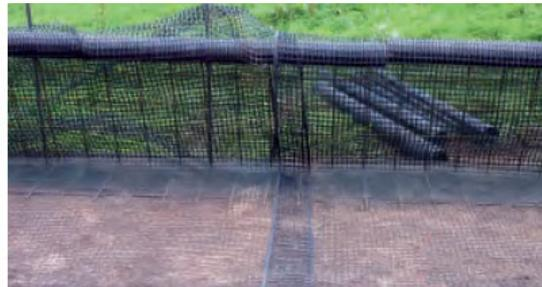
**4** Zugdrähte einhängen am Böschungsnetzfrontteil beim obersten horizontalen Draht ( $\varnothing$  8mm) und am Böschungsnetzbodenteil beim letzten horizontalen Draht ( $\varnothing$  8mm). Es ist darauf zu achten, dass die Zugdrähte übers Kreuz der Längs+ / Querdrähte vom Böschungsnetzfrontteil eingehängt werden. Diese im abwechselnden Abstand – beginnend beim ersten Senkrechtdraht vom Böschungsnetz, dann wieder nach 45 cm und wieder nach 60 cm und so weiter.
