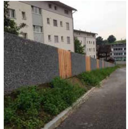
Der SteinHag ist in den Breiten 23 cm und 30 cm lieferbar. Die Gittermatten  $\varnothing$  3.5mm(senkrecht) und  $\varnothing$  6mm(waagrecht) werden mit Fixierhaken vor Ort montiert und mit Distanzhaltern vor Verformung gesichert. Die Maschenweite 25 x 100 mm ist perfekt geeignet für das maschinelle Einfüllen von Schotter oder Rundkorn 30/50 mm.
