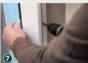
7. Fenster entsprechend des RAL-Leitfadens zur Montage (bei Nutzung von Hannoband®-3E BG1)<sup>3</sup> montieren. Randabstand für Bohrungen zur Fenstermontage beachten: Mindestens 20 mm.
