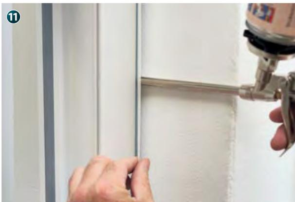
Die Fuge mit einem geeigneten Dämmstoff annähernd vollständig füllen.
