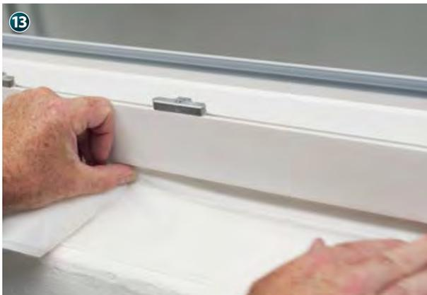
Im unteren Bereich lösen Sie beim Andrückvorgang den schmalen Abdeckstreifen und befestigen das Folienband am Fenster.
