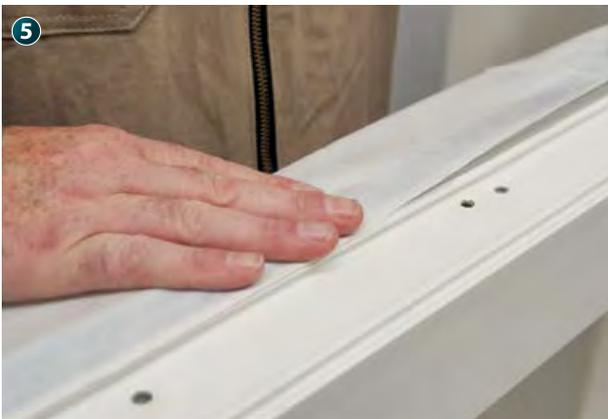
Beim Aufkleben der Hanno®-Folienbänder auf den Fensterrahmen nutzen Sie die ganze Breite des Klebestreifens und drücken diesen sorgfältig an. Ggf. ist eine Reinigung des Fensterprofils erforderlich, um die Oberfläche von Produktionsfilmen oder Tauwasser zu befreien. Es ist eine ausreichende Verklebung auf dem Fensterrahmen bzw. auf den Stegen des Fensterrahmens sicherzustellen.
