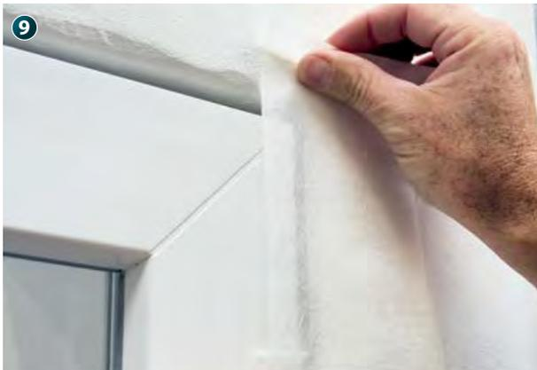
Mit den feuchtevariablen HANNO®-Folienbändern können Sie sowohl den inneren als auch den äußeren Anschluss abdichten. Alternativ ist der Einsatz der speziellen HANNO®-Folienbändern für außen oder für innen möglich.
