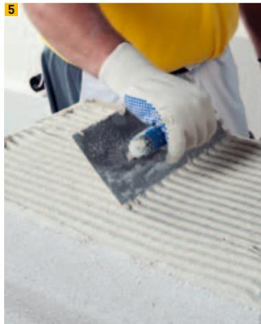
5 Multipor Leichtmörtel auf Dämmplatte auftragen
