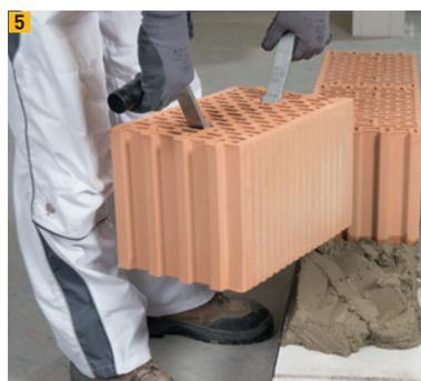
5 Montage du mur avec des briques classiques ou en béton léger
