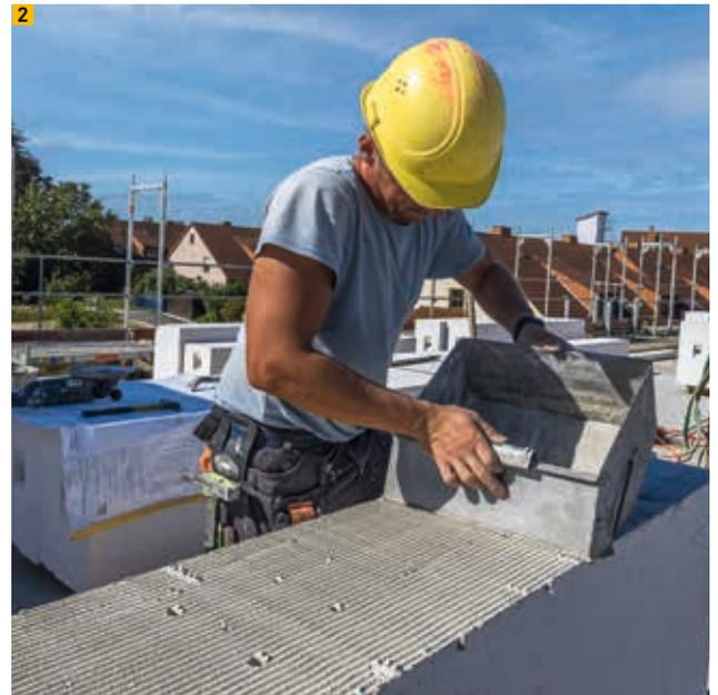
Zur Verarbeitung der Elemente wird Dünnbettmörtel auf die Stossfugenseiten aufgebracht.
