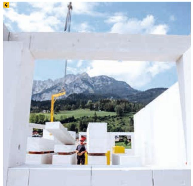
Neben den Wandelementen für alle Aussen- und Innenwände sind auch Ausgleichsteine, Stürze, Deckenelemente und Dachelemente Teil des Produktsortiments.
