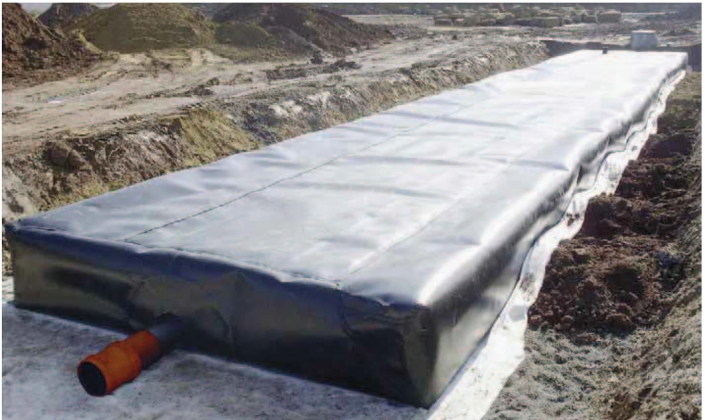
Für den Einsatz der RAUSIKKO Box als System zur Regenwasserspeicherung werden die Boxen mit einer Kunststoffdichtungsbahn ummantelt.
