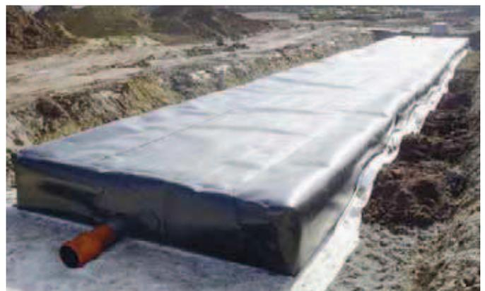
Regenwasserspeicher mit Folienummantelung
