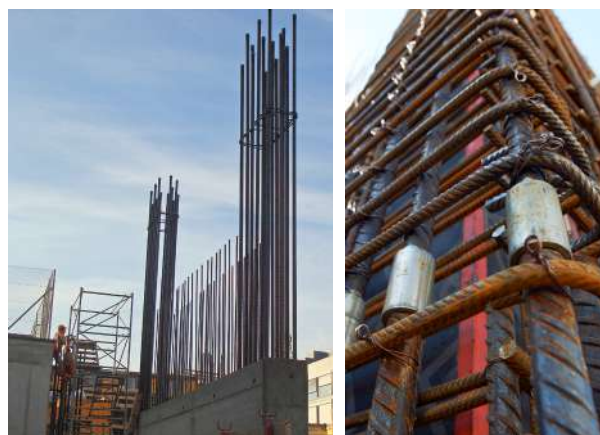
Mur parasismique avec armatures latérales concentrées.
