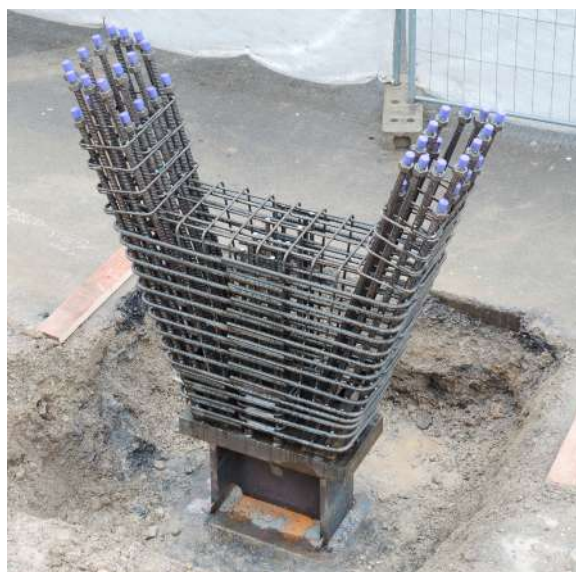
Armature haute résistance Top700 dans les piliers, avec liaisons par filetage BARTEC® TOP.
