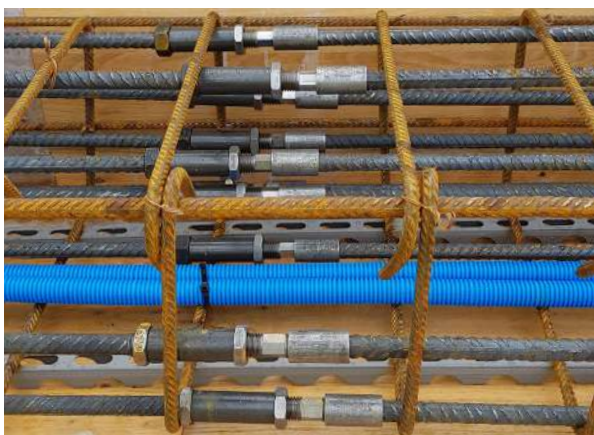
Armature en anneaux fermés avec liaisons LER dans les fondations du Chapeau de magicien (zoo pour enfants Knie, Rapperswil).
