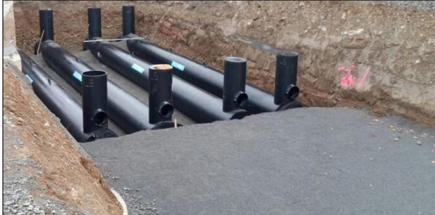
Anlage in perfekter Kombination, bestehend aus ENREGIS/Vivo Pipe®-System und einem nachgeschalteten ENREGIS®/Retentionssystem
