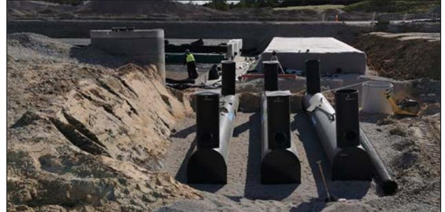
Kombination ideal aufeinander abgestimmter Komponenten der ENREGIS® Systemtechnik: ENREGIS/Vivo Pipe® Sedimentations-systeme, Behandlungsanlage sowie Retentionssystem
