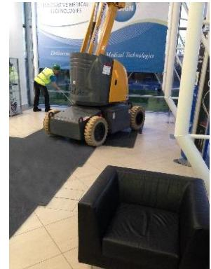
**EconoTrak** Bodenschutzplatten werden vorzugsweise zur Lastverteilung und zum Schutz von empfindlichen Bodenbelägen im Innenbereich eingesetzt. Die beidseitig leichte Profilierung der Oberflächen ermöglichen selbst bei nassen Verhältnissen ein sicheres Begehen der Platten und eine sichere Positionierung.
