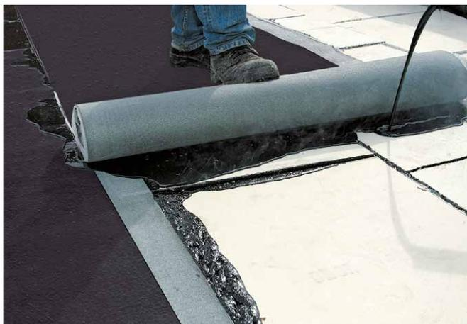
Verbrauch mind. 2,5 kg/m<sup>2</sup>, auf den BauderPIR KOMPAKT Dämmplatten aufgeklebt werden. Die Abdichtungsbahn so langsam einrollen, dass eine Bitumenwulst vor der Rolle entsteht. Es darf keine Luft unter der ersten Lage eingeschlossen werden.
