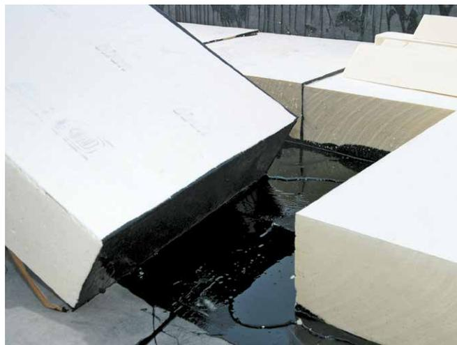
Heissbitumen mit  $180^\circ\text{C}$  auf die verlegte Dampfbremse giessen, Verbrauch mind.  $5 \text{ kg/m}^2$  je nach Untergrund auch deutlich mehr.
