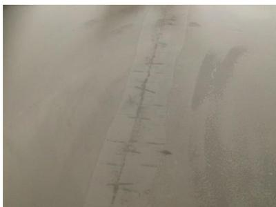
Joints de construction préparée
