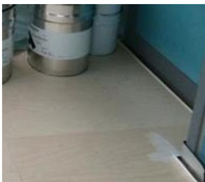
Pour finir on applique le CONIPUR 67 avec un rouleau micro fibre dans la règle de l'art afin d'éviter toute trace de rouleau. Limiter au maximum la zone de chevauchement entre deux bandes appliquées.
