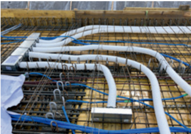
Esempi di solaio con installazioni impiantistiche in un edificio multipiano
