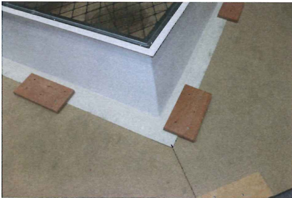
Abbildung 1: Befestigung der Oblichter am Boden.
