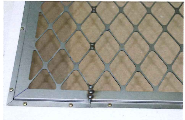
Abbildung 22: Oblicht Nr. 2 vor dem Versuch. Detailaufnahme mit Schweisstellen und den neuen Schrauben.
