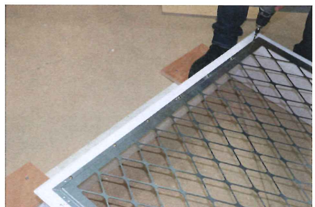
Abbildung 12: Montage der neuen Schrauben bei Oblicht Nr. 1 mit Gitter Nr. 2.
