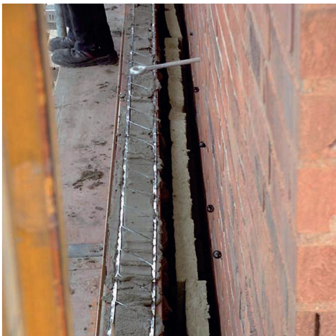
Mit MURINOX®-Lagerfugenbewehrung verstärktes Mauerwerk. Armature de joint d'assise MURINOX® pour mur linéaire et d'angle.
