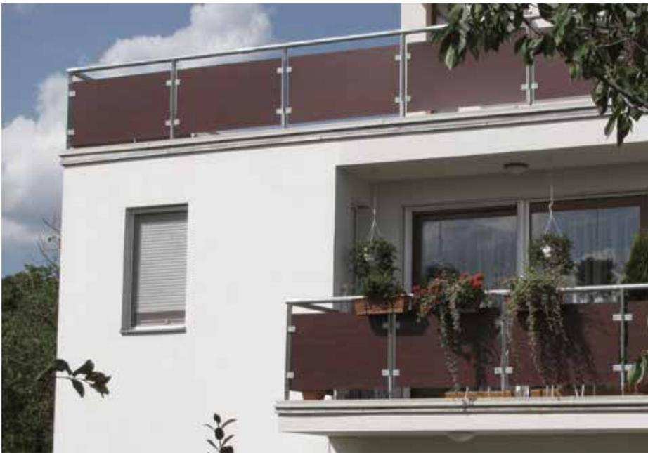
Les configurations des gardes corps étant différentes d'un projet à l'autre il faudra systématiquement prévoir un essai de résistance pour justifier de la résistance du système constitué (panneau & structures & ancrages & fixations). Les essais devront être réalisés selon les normes NF P 01.013 « Essais des gardes corps » et NF P 08.301 « Essais de résistance aux chocs ».
