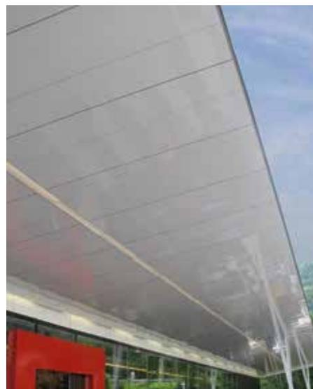
En applications sous face et faux plafond, les panneaux Max Exterior épaisseurs 6 ou 8 mm peuvent être fixés par vis auto perceuses ou rivets sur ossature métallique ou vis à bois sur ossature bois. Les variations dimensionnelles des panneaux imposent des fixations par points fixes et points coulissants.
