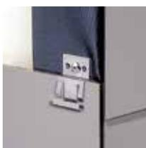
Les systèmes de fixations vis ou rivets seront en Inox A2 minimum (ou en Inox A4 en front ou bord de mer)
