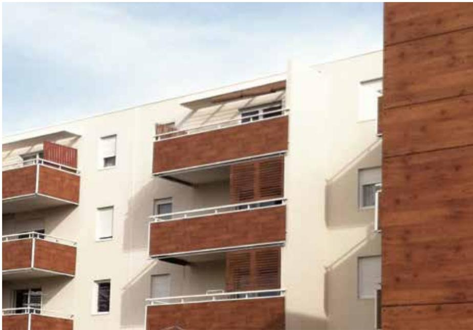
Les configurations des garde corps étant différentes d'un projet à l'autre il faudra systématiquement prévoir un essai de résistance pour justifier de la résistance du système constitué (panneau & structures & ancrages & fixations). Les essais devront être réalisés selon les normes NF P 01.013 « Essais des garde corps » et NF P 08.301 « Essais de résistance aux chocs ».
