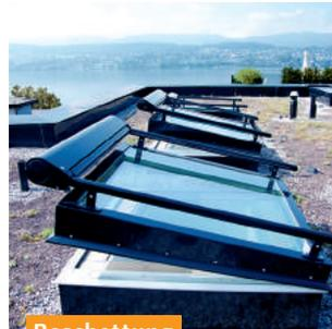
Anstelle einer Sonnenschutzverglasung kann die direkte Licht- und Wärmeeinstrahlung auch durch Beschattungen reduziert werden. Am effizientesten wirken aussen direkt auf den Rahmen des Glasoberlichts montierte Markisen oder Rollos. Sie sind regelbar, reduzieren die Hitze und lassen trotzdem Tageslicht ins Gebäude.
