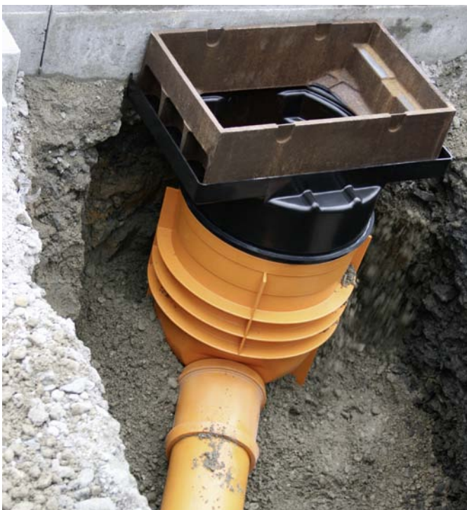
5 Gussaufsatz in den Aufsatzrahmen einlegen und RainSpot grob ausrichten.
