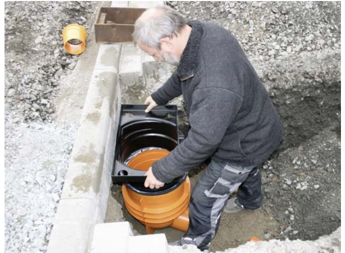
4 Aufsatzrahmen aufstecken.
