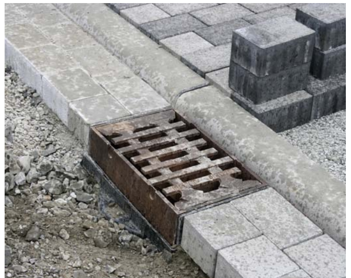
10 Rinnenpflaster vervollständigen. Dabei ggf. Dehnungsfugen einbauen bzw. Fugen vergießen.
