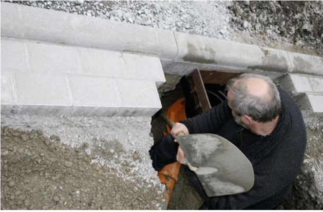
6 Hinter dem RainSpot mit Fundamentbeton verfüllen / hinterstopfen.
