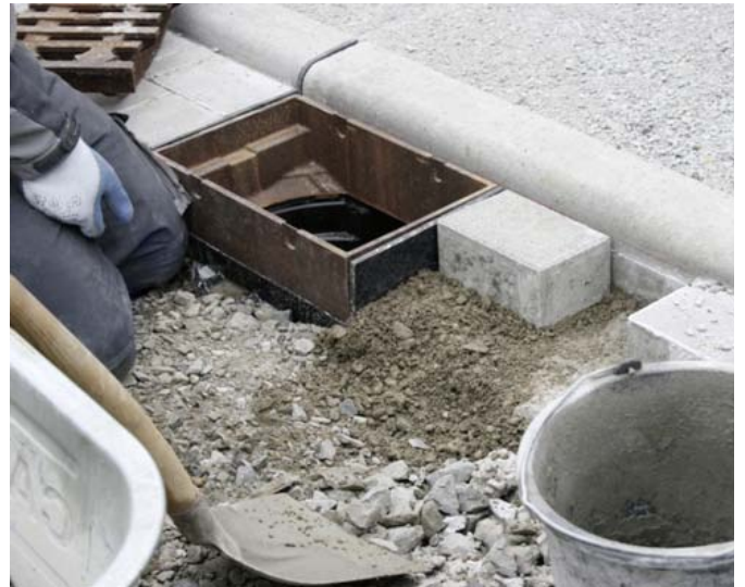
9 Fundamentbeton ringsherum feststampfen und Auflager für das Rinnenpflaster bilden.
