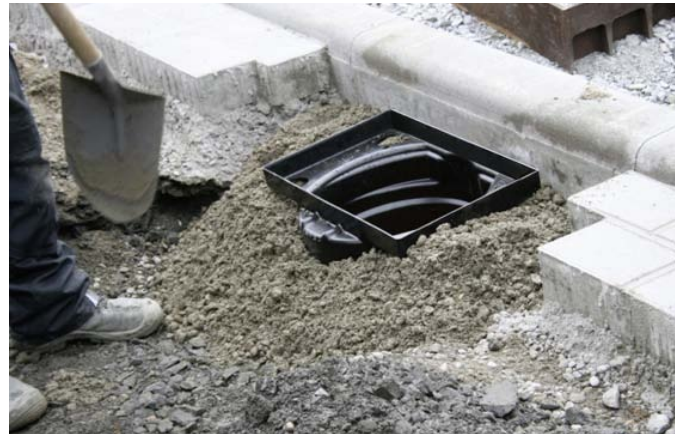
7 Grube lagenweise verfüllen und verdichten. Dabei unter dem Aufsatzrahmen Kegel aus Fundamentbeton aufbauen.
