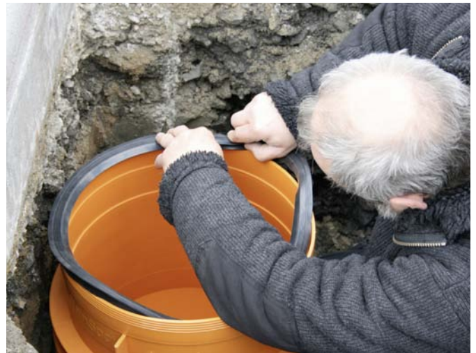
2 Dichtring aufsetzen.
