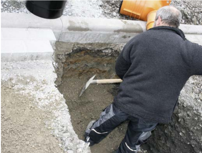
1 Boden unter dem Randstein abstechen. Fundamentbeton einbringen.
