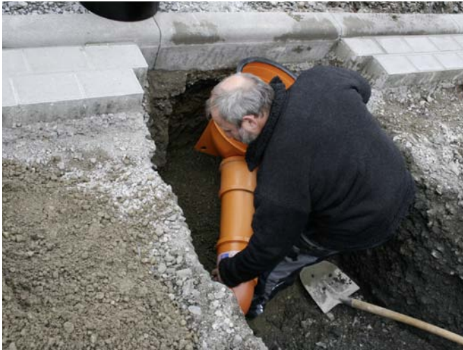
3 RainSpot mit dem Verbindungsrohr auf Fundamentbeton setzen.
