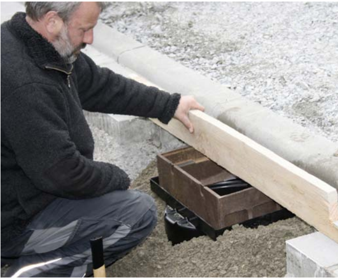
8 Den Aufsatzrahmen mit Fundamentbeton unterstopfen und Gussaufsatz auf die richtige Höhe bringen. Hierzu Aufsatzrahmen zunächst leicht überhöht einbauen (1-2 cm) und dann auf die gewünschte Höhe klopfen. Dabei muss der Fundamentbeton gut verdichtet werden. Ein nachträgliches Anheben des Aufsatzrahmens oder anderes Auflockern des Fundamentbetons ist unzulässig.
