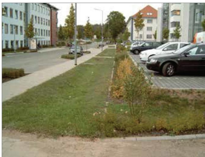
*Versickerungsmulde einer Mulden-Rigole nach Fertigstellung*
