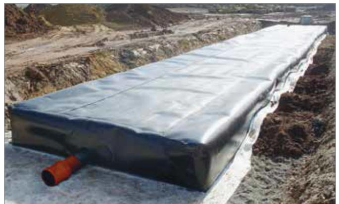
Regenwasserspeicher mit Folienummantelung
