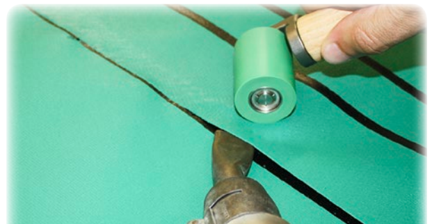
Verschweissung der Folie mit Handschweißgeräten.
