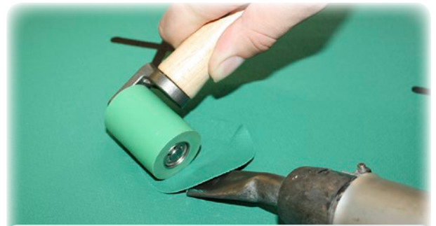
Beschädigungen mittels kreisrundem Zuschnitt nachbessern.
