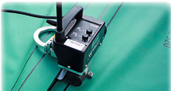
Verschweissung der Folie mit Schweißautomaten.
