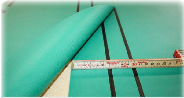
Unterdachfolie auf fester Unterlage wie Schalung oder trittfeste Dämmung ausrollen und mit geeigneter Überlappungen versehen.
