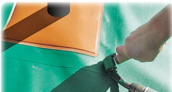
Detaillösungen mittels zahlreichen vorgefertigten Anschluss-teilen.
