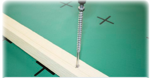
Folie in der Fläche mit Konterlattung fixieren. Durchdringungen mittels Nageldichtungen oder Nageldichtbänder abdichten.
