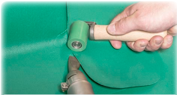
Verschweissung der Folie mit Handschweißgeräten.
