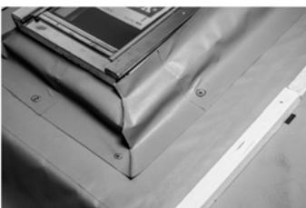
5. Fertig verschweisste Manschette über die Dachfensterzarge ziehen, ausrichten, mittels Tacker auf der Zarge befestigen und Abdichten des oberen Abschlusses mit GYSO-Polyflex 444, GYSO-Polystrong 8966 oder mit GYSO-Tape V-712/V-775 vornehmen
