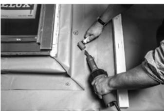
6. Manschette von oben nach unten mit der Unterdachbahn dicht verschweissen.
