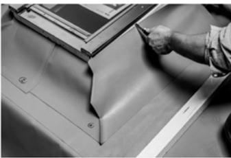
2. Eckteile von unten nach oben provisorisch verlegen und überschüssiges Material unter Berücksichtigung einer Überlappung von jeweils ca. 6 - 8 cm wegschneiden.
