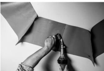
4. Teile entfernen und auf einer planen Unterlage (Arbeitstisch, Gerüstbrett etc.) unter Berücksichtigung der Nummerierung, entsprechend der Markierungen von Hand verschweissen.
