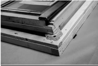
1. Enlever la tôle recouvrant le châssis de la fenêtre de toiture et positionner le châssis de la fenêtre
