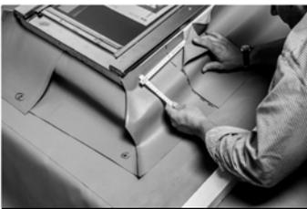
3. Überlappung genau anzeichnen und Teile im Uhrzeigersinn von unten rechts beginnend nummerieren.
