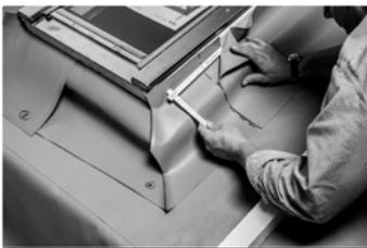
3. Tracer précisément le recouvrement et numéroter les pièces dans le sens des aiguilles d'une montre en commençant en bas à droite
