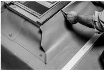
2. Placer provisoirement les parties d'angle du bas vers le haut et découper le matériau excédentaire en prévoyant un recouvrement d'env. 6 – 8 cm
