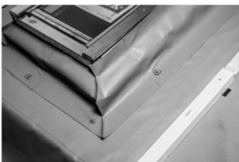
5. Tirer le manchon une fois soudé par-dessus le cadre de la fenêtre de toiture, l'ajuster, le fixer sur le cadre au moyen d'agrafes, et étancher l'extrémité supérieure avec la GYSO-Polyflex 444, GYSO-Polystrong 8966 ou le GYSO-Tape V-712/V-775.
