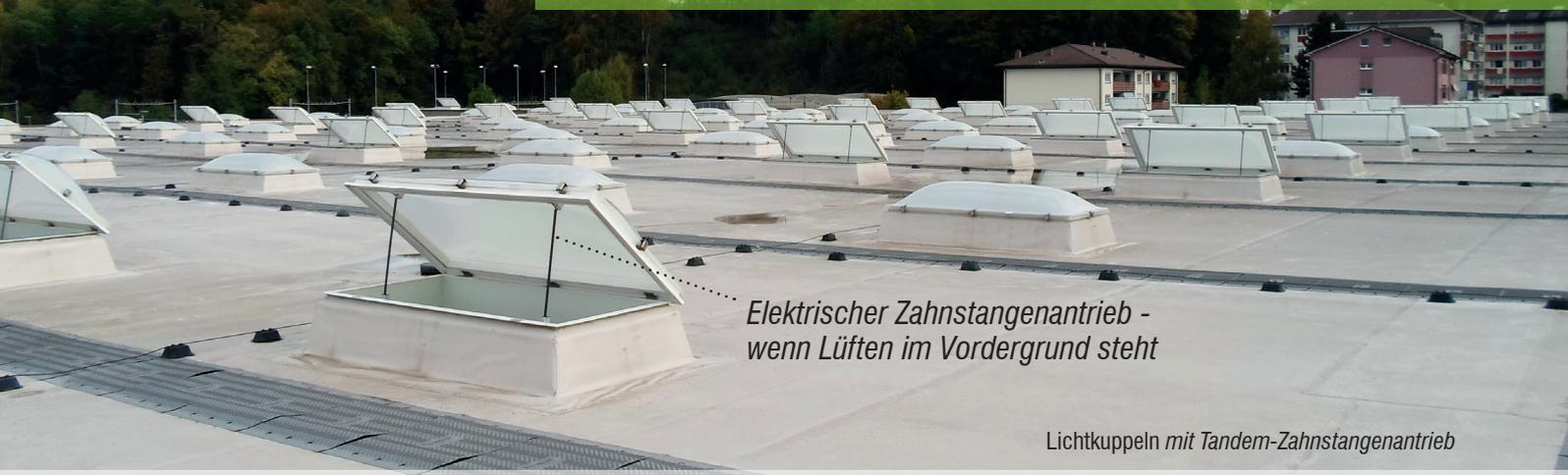
*Elektrischer Zahnstangenantrieb -
