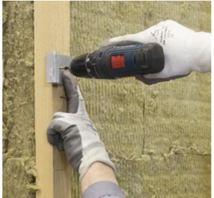
Die Verwendung der Schablone garantiert die optimale Ausrichtung der Haften und eine einfache Verlegung der Anschlussprofile.
