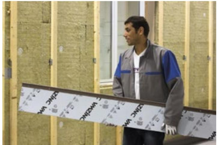
Die Paneele werden von unten nach oben durch Einrasten ineinander verlegt.
