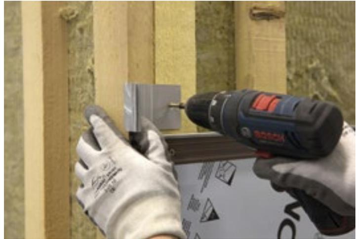
Achten Sie darauf, die Paneele bündig mit dem Anschlusswinkel zu installieren.
