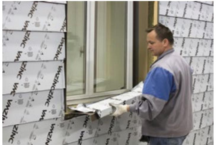
**Laibung** Zuschnitt der Laibungsprofile und Einschieben in die Einsteckprofile. Einrasten in die Universalhaften.
