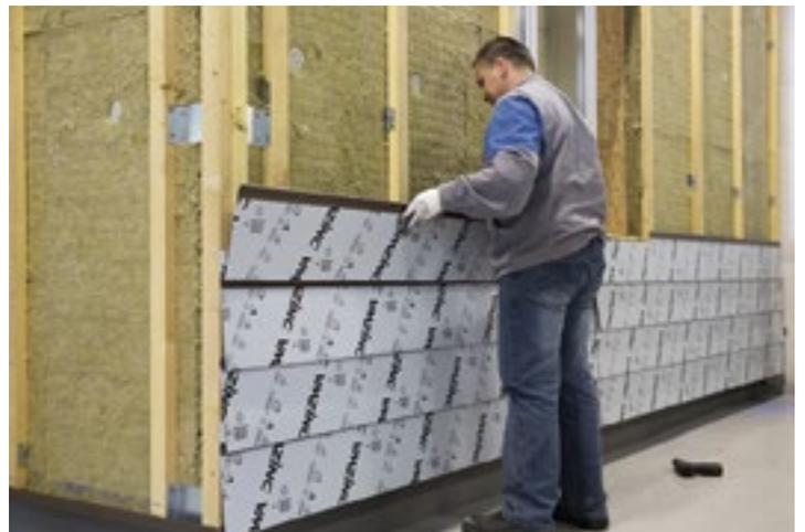
Mit einer Wasserwaage ist die horizontale Ausrichtung der Paneele regelmäßig zu überprüfen.
