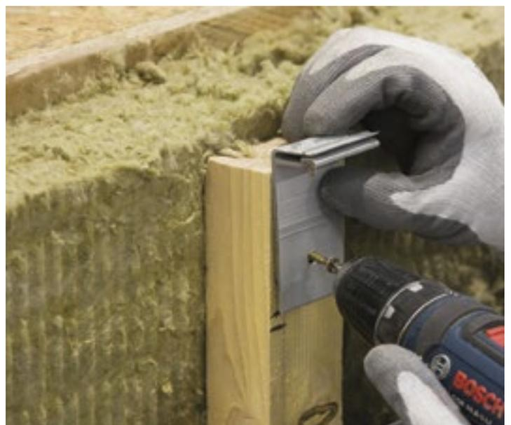
Die Befestigung des letzten Paneels unter der Fensterbank erfolgt über selbstschneidende Schrauben (Durchmesser 4,8 mm, Kopf 12 mm).
