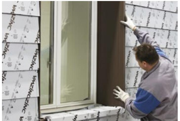
**Sturz** Zuschnitt des Sturzprofils und Einschieben in das Einsteckprofil. Einrasten in die Universalhaften.
