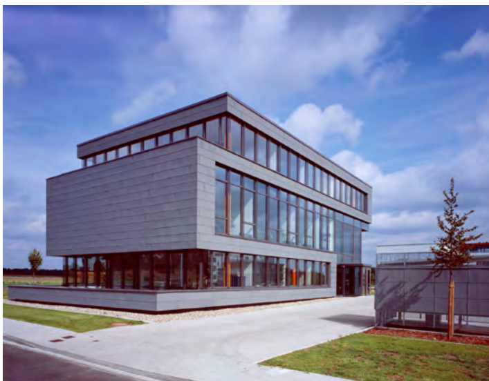
Bürogebäude in Münster Architekt: Heyen + Lippross
