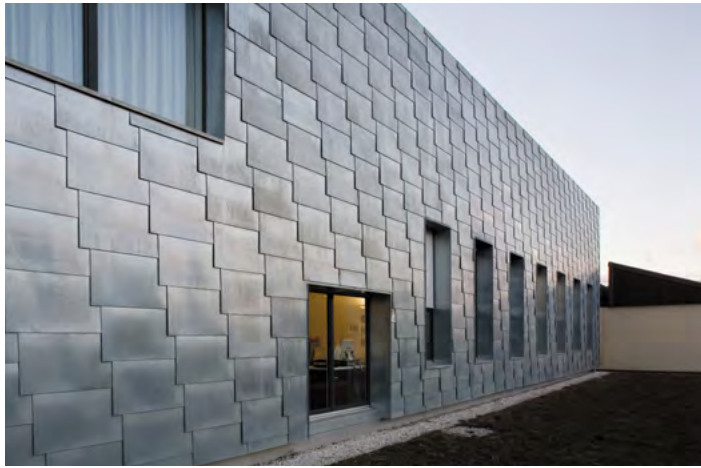
Weinhandlung in Penthalaz, Architekt: Deillon Delley Sarl
