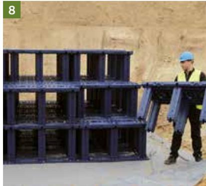
Für eine schnelle und sichere Verlegung belassen Sie seitlich (idealerweise dort, wo ggf. integrierte Schachtzugänge entstehen sollen) einen treppenartigen Aufstieg in obere Lagen. Lassen Sie die Schachtzugänge/-anschlussstellen frei, um entsprechende Durchgänge für Inspektions- und Wartungsgerät nachträglich herzustellen.
