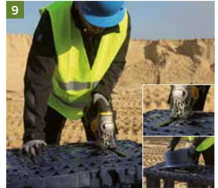
Für die Herstellung der Inspektions- und Reinigungsschächte (I+R-Schächte) sind die Durchgänge in den Speicherelementen an den hierfür vorgesehenen Trennkanten mit einer Stichsäge zu öffnen. Schachtdurchführungen sind mit einer Säge gekennzeichnet und befinden sich umlaufend um die Handgriffe. In der obersten Lage sind entsprechend der gewünschten Schachtdimension die Schachtanschlussstützen einfach aufzusetzen und einzurasten.
