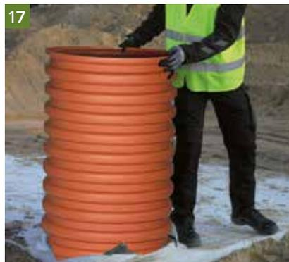
Abschliessend sind – falls vorhanden – die I+R-Schächte herzustellen. Hierzu ist das Schachtrrohr entsprechend der gewählten Dimension (DN/ID 315, 425 oder 600) auf den freigelegten Schachtanschlussstutzen aufzusetzen. Der weitere Boden- und Schachtaufbau erfolgt gemäss Planungsvorgaben mit entsprechender Abdeckung und in Übereinstimmung mit der ZTVE-StB 09.
