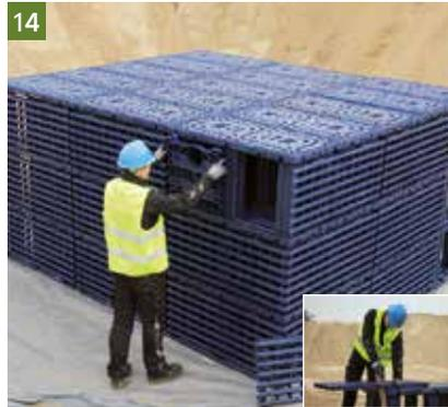
Offene Stellen können mit einer halben Seitenplatte verschlossen werden. Die Seitenplatte ist mithilfe einer Säge mittig zwischen dem Führungsdoppelsteg in zwei Teile zu sägen. Bei der Montage halber Seitenplatten ist darauf zu achten, dass der rechte Teil am rechten Ende und der linke Teil entsprechend auf der linken Seite der Rigole eingehängt wird, damit ein sauberer Abschluss der Speicherelemente ohne scharfe Trennkanten erzielt wird.
