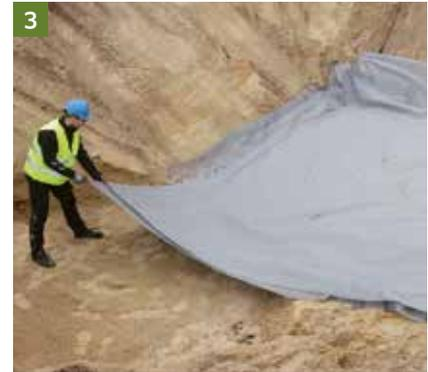
Die Aufstandsfläche ist zudem mit Vlies auszulegen. Hierbei ist zu beachten, dass das Vlies mit ausreichender Überlappung (min. 0,50 m), ohne Beschädigungen und idealerweise quer zur Grabenlängsachse verlegt wird. Die Rollenware ist gemäss Rigolenabmessung vorzubereiten. Zur Ermittlung der benötigten Menge gilt die Faustformel Umfang + 0,5 m Überlappung. Für die Anzahl der Bahnen sind zusätzlich die Stirnseiten mit jeweils 0,5 m Überlappung zu berücksichtigen.
