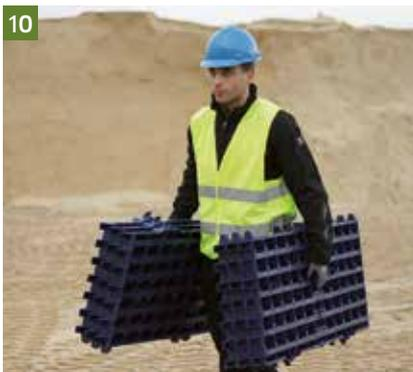
Nachdem die Rigole vollständig verlegt ist, sind umlaufend die Seitenplatten anzubringen. Zum Transport können jeweils drei Platten ineinander gehängt und somit zeitgleich sechs Platten transportiert werden. Für eine schnelle Verlegung können die Seitenplatten am besten zunächst zur Rigole transportiert und dann einzeln eingehängt werden.
