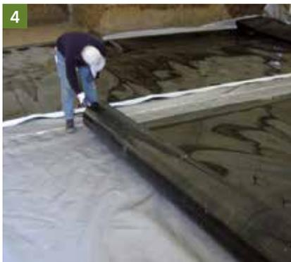
Beim Einsatz als Regenwasserspeicherung sind die Speicherelemente mit einer PE- oder EPDM-Folie wasserdicht zu ummanteln bzw. einzuschweissen. Die Folie ist dabei vor mechanischen Beschädigungen mittels einer Vliesschicht zu schützen. Wir unterstützen Sie bei Ihrem Vorhaben gerne durch Kontakt zu zertifizierten Fachbetrieben vor Ort.
