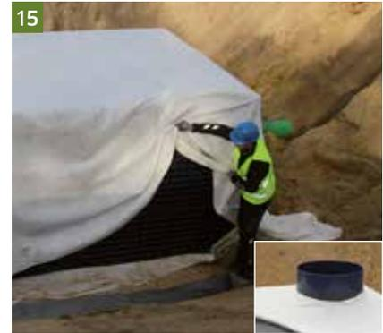
Ist die Rigole umlaufend vollständig verschlossen, ist die Vliesummantelung fertig zu stellen. Hierbei ist darauf zu achten, dass das Vlies dicht an den Speicherelementen anliegt und keine Fremdkörper zwischen die Elemente und die Vliesummantelung dringt. An Rohr- oder Schachtanschlüssen ist das Vlies an diesen Stellen entsprechend kreuzförmig einzuschneiden. Die Vliesbahnen sind dann 0,5 m zu überlappen und mit einem geeigneten Tackerhammer an den Stosskanten zu befestigen.
