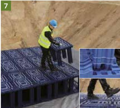
Für die Verlegung weiterer Lagen werden keine Bodenplatten benötigt. Das Speicherelement kann direkt auf die sofort begehbare untere Lage gesetzt werden. Hierzu sind die 6 Säulen in die Aussparungen des unteren Speicherelements einzurasten. Jedes seitlich angrenzende Element kann auf die untere Lage abgesetzt und an das bereits verlegte Element der neuen Lage herangeschoben werden. Das Einrasten der Säulen sowie der integrierten Verbinder erfolgt von allein.
