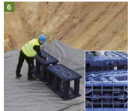
Das Speicherelement ist entsprechend den Planungsvorgaben auf das mit Vlies/Folie ausgelegte Planum aufzusetzen. Jedes weitere Element ist leicht von oben und direkt an das bereits verlegte Speicherelement anzusetzen. Durch integrierte Verbinders greifen die einzelnen Speicherelemente direkt ineinander und werden horizontal in ihrer Lage gesichert. Es werden keine zusätzlichen Verbinders oder Werkzeuge benötigt.
