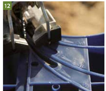
Entsprechend den Planungsvorgaben sind dann die Rohranschlüsse herzustellen. Hierfür stehen sogenannte Universalanschlussplatten zur Verfügung. Die Universalanschlussplatten enthalten dimensionsbezogene Vorprägungen für einen Anschluss von Rohren in DN/OD 160, 200, 315 und DN/OD 400. Je nach Dimension (mit Ausnahme von DN/OD 160) ist der gewünschte Ausschnitt mit einer handelsüblichen Stichsäge freizuschneiden. Die Anschlussplatte ist an der gewünschten Stelle durch Einrasten einzusetzen.
