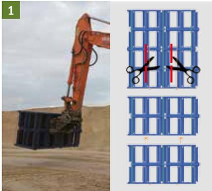
Die Basisspicherelemente werden in zwei durch Kunststoffspannbänder miteinander verbundenen, Einzelpaketen angeliefert. Dadurch können die 32 Basisspicherelemente in eins mit einem Gabelstapler entladen werden. Vor der weiteren Verwendung empfiehlt es sich jedoch, die Einzelpakete voneinander zu lösen. Hierzu sind zunächst die zwei Spannbänder links und rechts (gemäss Abbildung) zu durchtrennen. Dann ist die obere Einheit abzuheben und kann weiter verwendet werden.
