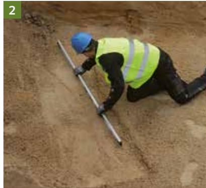
Vor dem Einbau der Rigole ist die Baugrube gemäss Planungsvorgaben herzustellen. Hierbei sind die DIN 18300 (Erdarbeiten) und DIN 4124 (Baugruben und Gräben) zu beachten. Ferner ist eine Rigolenaufstandsfläche entsprechend DIN EN 1610 aus einer vollflächigen, 10 cm dicken Sauberkeitsschicht aus Splitt bzw. Grobsand (ohne Feinsandanteil) herzustellen. Der Arbeitsraum für die Rigole bemisst sich zzgl. eines Mindestarbeitsraums von ca. 1,0 m.
