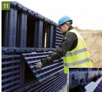
Das Einhängen der Seitenplatten kann durch integrierte Aufhängungen (oberhalb des Wavin-Logos auf der Anschlussplatte) einfach durchgeführt werden. Hierzu sind die Seitenplatten an den dafür vorgesehenen Aufnahmen rechts und links jeweils zwischen den integrierten Horizontalverbindern einzuhängen. Nach dem Einhängen können die Seitenplatten einfach losgelassen werden und rasten so durch das Herunterfallen direkt in das Speicherelement ein.
