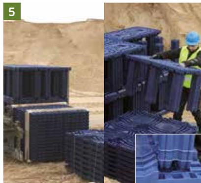
Die Q-Bic Plus Elemente werden komponentenweise angeliefert und sind entsprechend der Verlegung dicht beieinander zu lagern. Es ist auf eine ebene, feste Stellfläche zu achten. Die Verlegung beginnt für die unterste Lage mit dem Verbinden des Speicherelementes mit der Bodenplatte. Hierzu ist das Speicherelement mit 6 Säulen in die hierfür vorgesehenen Aussparungen der Bodenplatte einzurasten.
