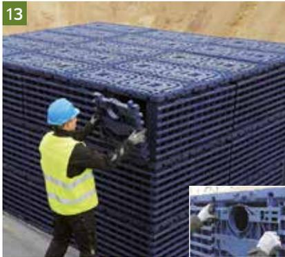
Die Anschlussplatte kann, je nach Einsatzzweck, mit Öffnung oben (z.B. für eine maximale Ausnutzung des Versickerungsvolumens) oder unten (z.B. für eine nahezu vollständige Entleerung bei der Rückhaltung) eingesetzt werden. Generell kann die Anschlussplatte in beliebiger Lage angeschlossen werden. Sie verfügt zudem über einen integrierten, Rohrstopper' welcher direkt die optimale Einstecktiefe des Spitzendes definiert.
