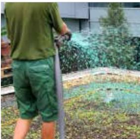
ND Hydroseeder - Sprösslinge werden mit Mulchschicht besprüht
