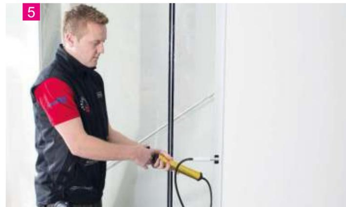
5 Das Ausfahren der Paneele geschieht mit einer Vakuumpumpe
