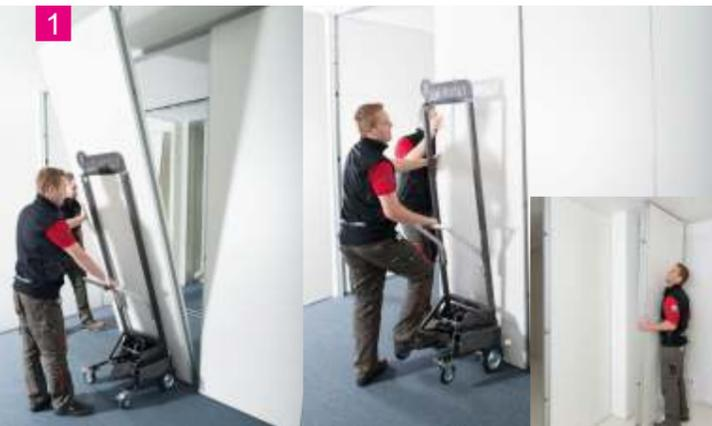
1 Unser ergonomischer Handwagen macht das Hantieren der Paneele und den Zusammenbau der Wände äußerst einfach
