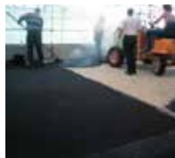
9. Schon nach 3 Stunden lässt sich der bis zu 250 °C heiße Gussasphalt aufbringen.
