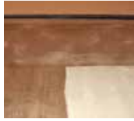
2. Bereits nach 45 Minuten ist die Grundierung überarbeitbar.
