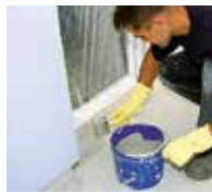
12. Die Versiegelung Triflex Cryl Finish 205 auftragen und ...
