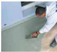
11. ... mit einer Kelle aufziehen und egalisieren.
