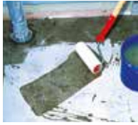
1. Wandanschluss und Fläche grundieren.
