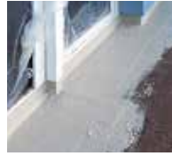
5. Eine zweite Schicht Triflex ProDetail wird aufgebracht.
