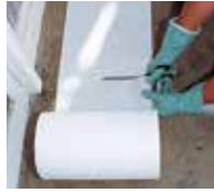
2. Triflex Spezialvlieszuschnitte vorbereiten.
