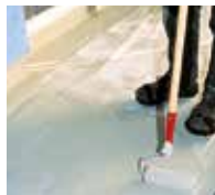
9. Eine zweite Schicht Triflex ProTerra wird aufgebracht.
