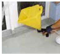
13. ... Triflex Micro Chips einblasen.
