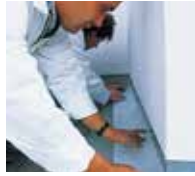
3. Triflex Spezialvlies blasenfrei einlegen und ...
