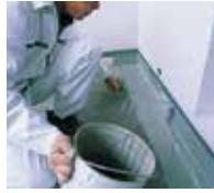
2. Anschlüsse mit Triflex ProDetail vorlegen.
