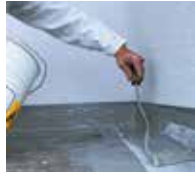
4. ... mit Triflex ProDetail satt nachlegen.
