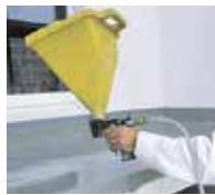
10. ... Triflex Micro Chips einblasen.
