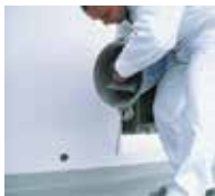
5. Die Flächenbeschichtung Triflex ProFloor ...
