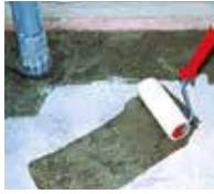
1. Wandanschluss und Fläche grundieren.
