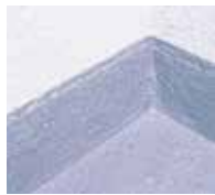
11. Der Balkon ist innerhalb eines Tages fertig.
