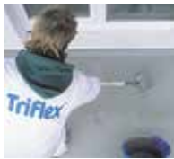
9. ... dann auf die Fläche aufbringen und ...
