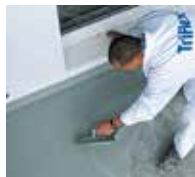
6. ... mit einer Kelle aufziehen und ...
