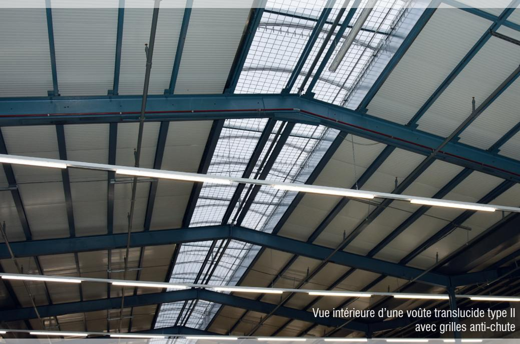
Vue intérieure d'une voûte translucide type II avec grilles anti-chute
