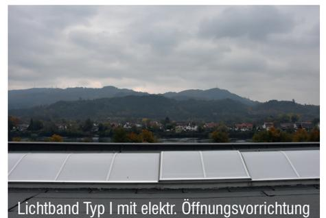
Lichtband Typ I mit elektr. Öffnungsvorrichtung
