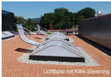
Lichtband mit RWA-Steuerung
