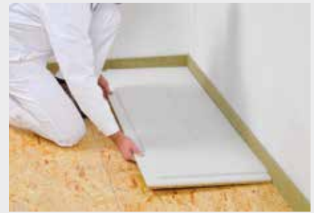
Verlegen der fermacell Estrich-Elemente
