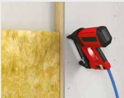
Klammern auf Holzunterkonstruktion
