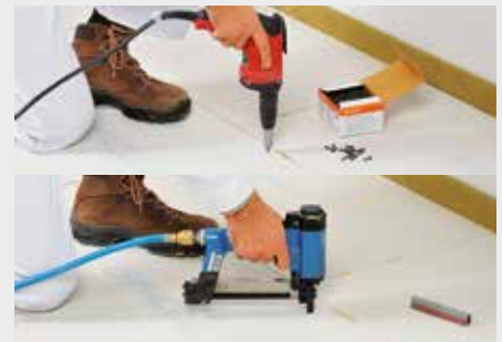
Verschrauben oder klammern (mit Spezial-Spreizklammern) innerhalb von 10 Min.
