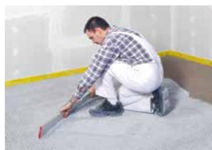
fermacell Wabenschüttung abziehen
