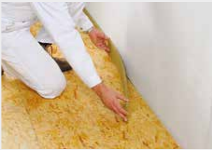
Randdämmstreifen verlegen und in den Ecken stumpf stossen
