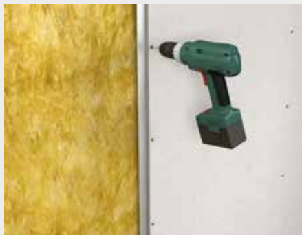
Schrauben auf Metallunterkonstruktion
