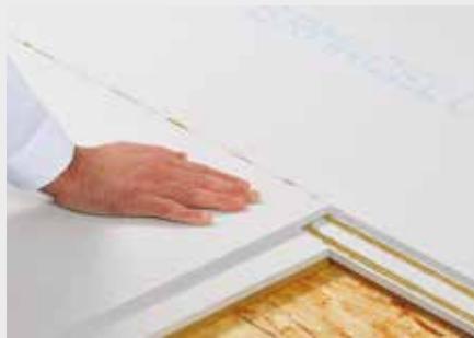
Verkleben der Elemente mit vollständig gefüllten Fugen
