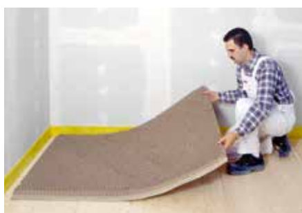
fermacell Estrich-Wabe verlegen
