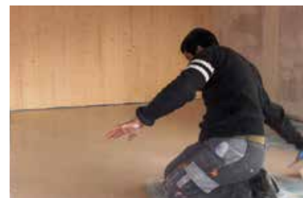
Nochmalige Flächenspachtelung fermacell Boden-Nivelliermasse (Q2 und Q3)
