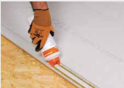
Auftragen des fermacell Estrich-Klebers im Falzbereich
