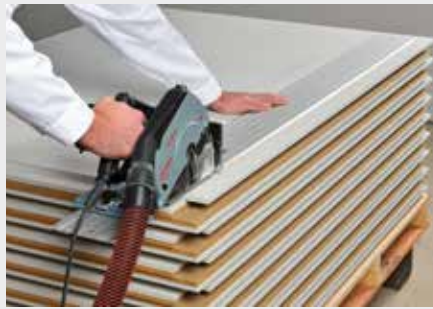
Absägen des überstehenden Falzes für die erste Verlegereihe
