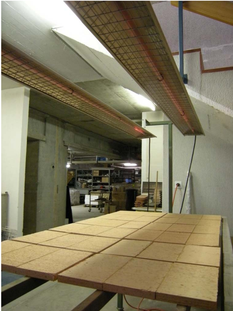
Abbildung 3: Sichtseitenplatten unter dem Infrarotstrahler (10h Austrocknung).
