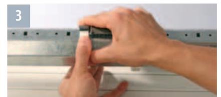
3 Befestigungsringe einrasten – fertig!
