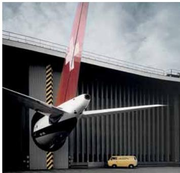
Tor mit enganliegender Öffnung für den hinteren Flugzeugteil. Gilgen Door Systems hat seit 1961 Erfahrung im Hangarbereich.
