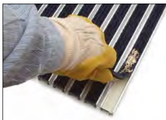
Importante: asportare sporcizia, reps e resti di colla dal profilo di alluminio (per es. con uno scalpello da legno).
