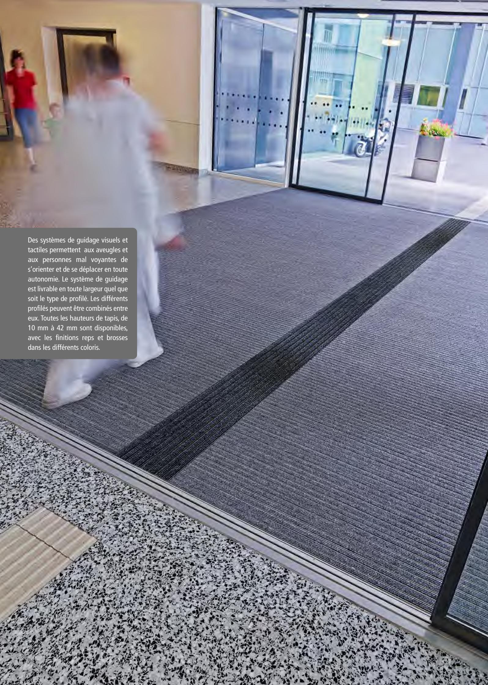
Des systèmes de guidage visuels et tactiles permettent aux aveugles et aux personnes mal voyantes de s'orienter et de se déplacer en toute autonomie. Le système de guidage est livrable en toute largeur quel que soit le type de profilé. Les différents profilés peuvent être combinés entre eux. Toutes les hauteurs de tapis, de 10 mm à 42 mm sont disponibles, avec les finitions reps et brosses dans les différents coloris.
