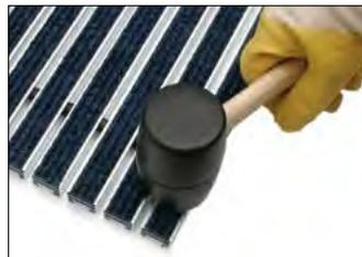
Positionner la nouvelle bande reps après avoir collé le ruban adhésif double face sur le profilé. Terminer la mise en place à l'aide d'un maillet caoutchouc pour bien plaquer l'insert reps dans la cavité du profilé.
