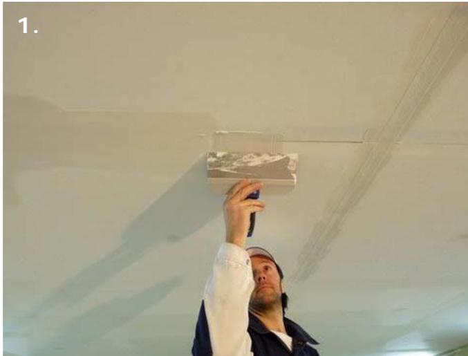
1. Mono TE Füller in die Fugen einspachteln und gleichmäßig auftragen
