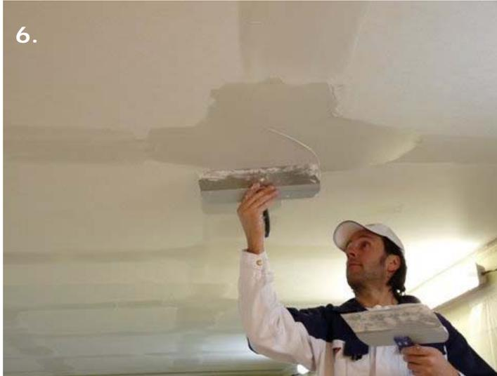
6. Auftragen einer zweiten Schicht mit dem Fugenfüller der Mono TE
