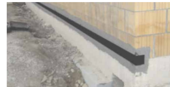
Einfache und direkte Verklebung des Fugenbandes auf Mauerwerk und Betonfundament.
