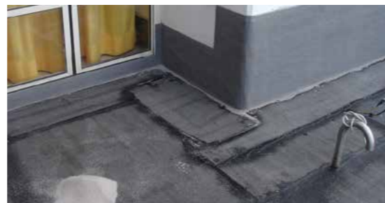
Horizontal in die bituminöse Abdichtung eingeflämmt und vertikal kraftschlüssig und hinterlaufsicher mit dem Epoxidharzkleber auf den Untergrund geklebt.
