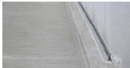
Direkte Verklebung des Fugenbandes auf die Betonflächen.
