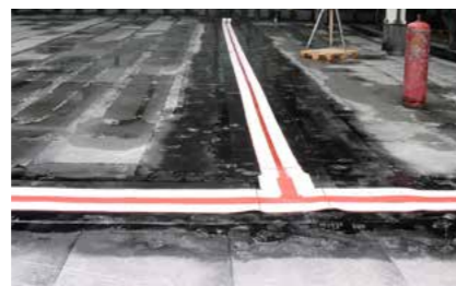
Kombination verschiedener Bandtypen (z. B. Übergänge RL 100–40).
