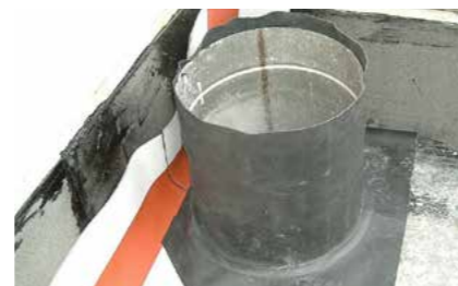
Einfassungen lassen sich in das Band vulkanisieren.
