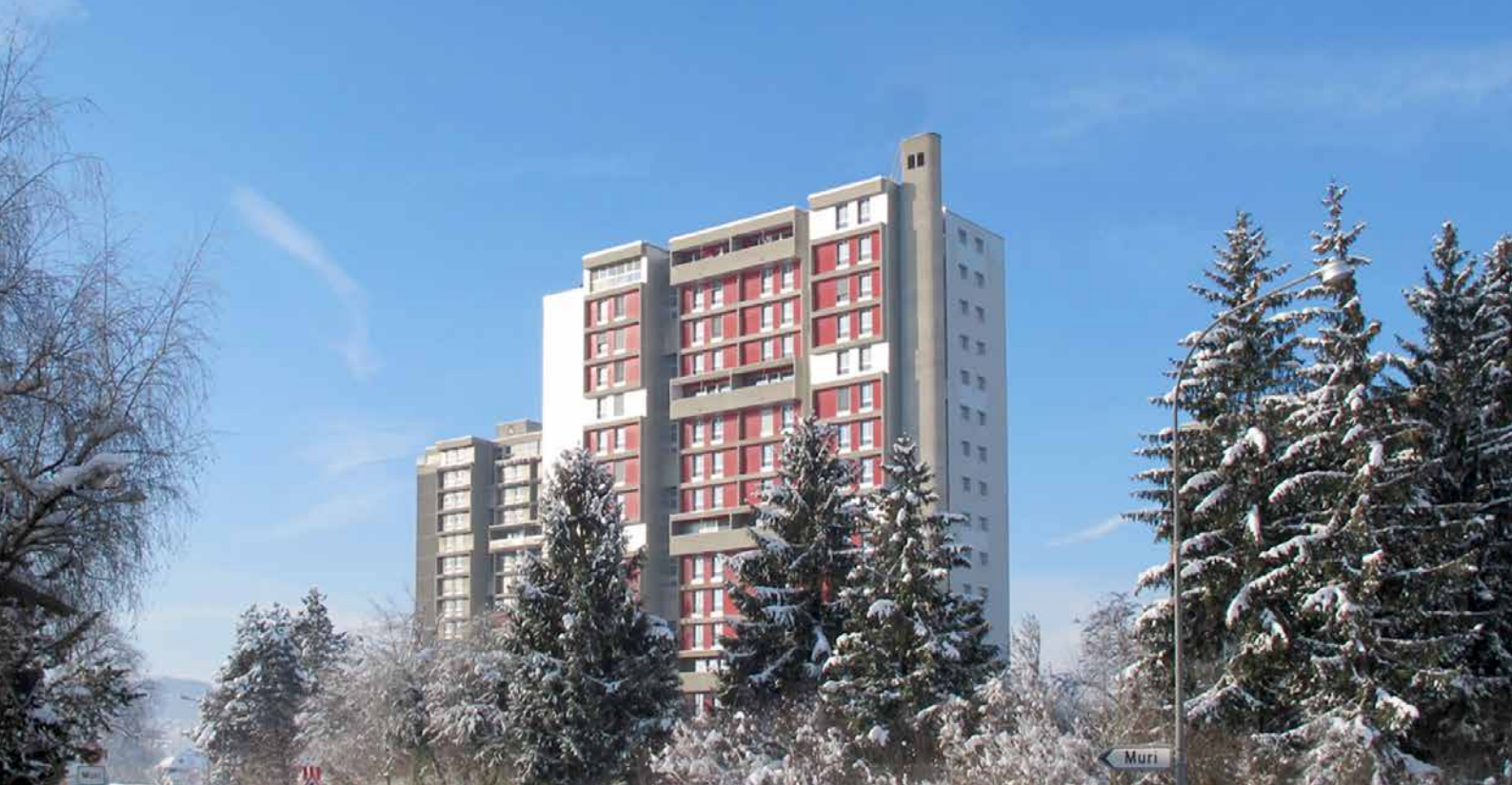
Sanierung eines Mehrfamilienhauses in Muri bei Bern
